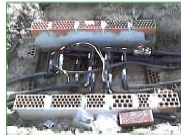
Figura 4. Ejecución del intercambiador de calor enterrado
