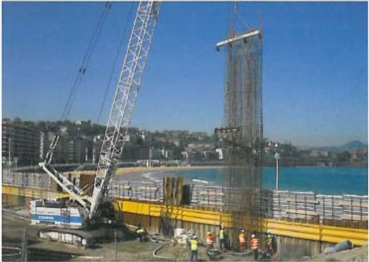
FIGURA 20. Introducción conjunta de la armadura y las sondas geotérmicas en un panel contiguo al Paseo de la Cancha. Se observa también la utilización de bloques para evitar el descalce de un tramo del muro del pozo.
