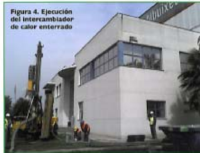
Figura 4. Ejecución del intercambiador de calor enterrado
